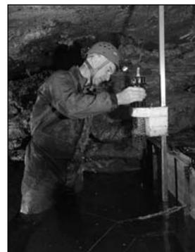
*Travaux de maintenance (une fois par mois) sur une sonde de détection des hydrocarbures placée au niveau d'un déshuileur sur le cours souterrain de la Milandrine.*
