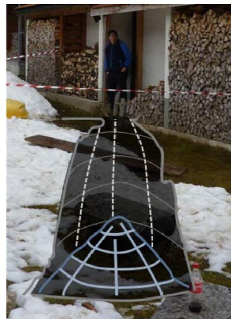
Effondrement de 3 m de profondeur devant la porte d'une maison, lié à l'infiltration de l'eau du toit.
